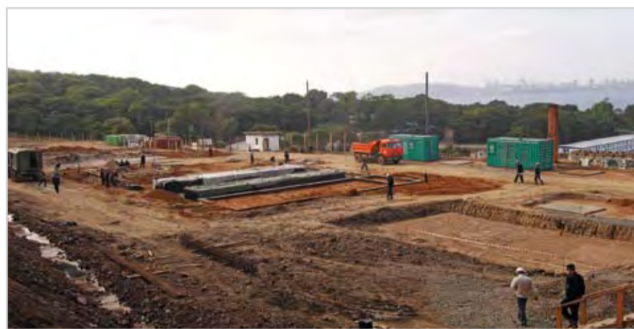
Так выглядит площадка строительства. Полная мобилизация всех ресурсов
